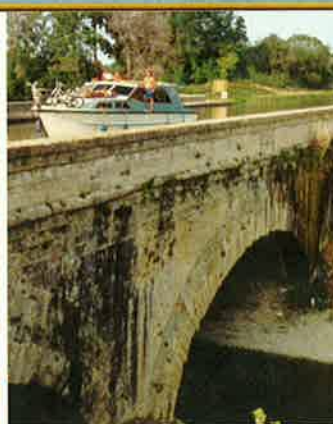
Un pont-canal à Béziers
